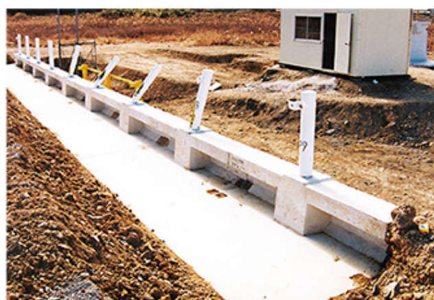
衝突後の状況（補強土壁上）
