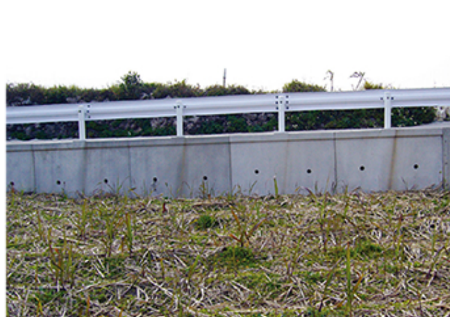
大度1号集落道整備工事（糸満市）
