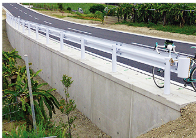
町道150号・276号線道路改良工事（南風原町）
