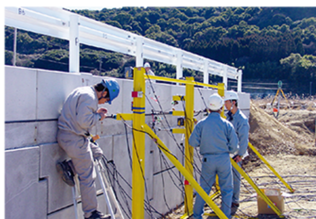
衝突実験前（補強土壁上）
