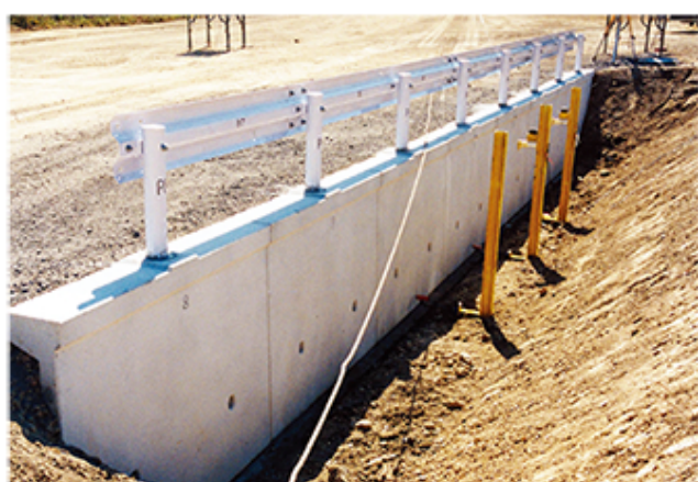
衝突実験前（直接基礎上）
