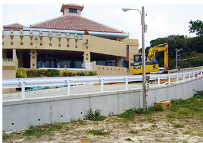
平成18年度漢那浜原線道路改良工事（宜野座村）
