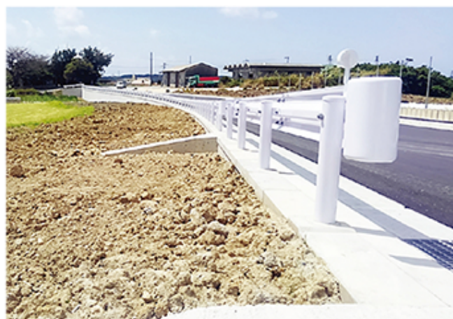
真壁前田原道路改築工事（糸満市）
