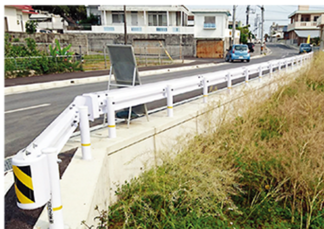
上江洲中央線道路整備工事（うるま市）
