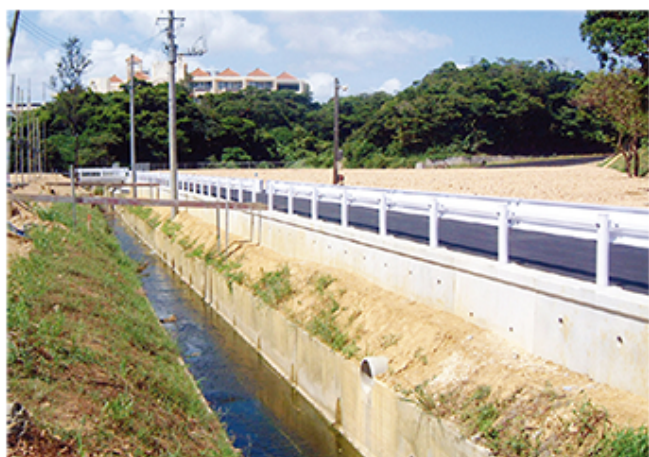
農道池原3号線整備工事（沖縄市）
