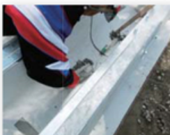
⑤ 連結部モルタル詰め
