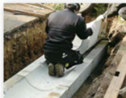
③ 側溝据え付け
