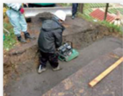
① 基礎材敷設
