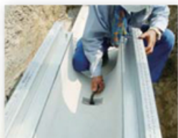
④ 固定ボルト締め
