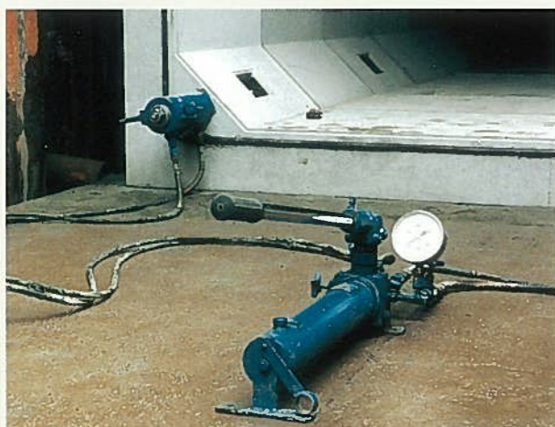
PC鋼棒による縦方向連結の施工
