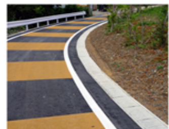
ズレ止め機能を設ける事により、坂道でもきちんと4枚納まります。
