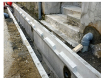
落蓋式なので、全面開口してのメンテナンスが容易にできます。
