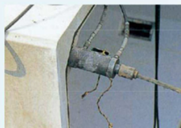
ジャッキによる緊張
