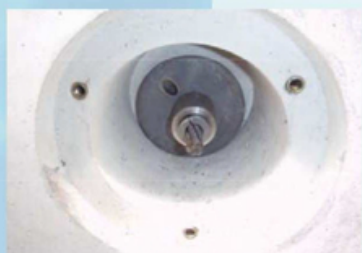
定着状況 (端面定着部)
