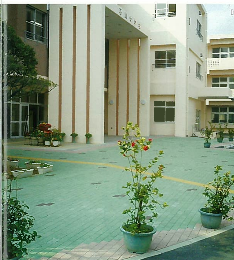
I. 石川中学校 表層ガラス透水性インターロッキング (100×200×60) 発注者：うるま市役所
