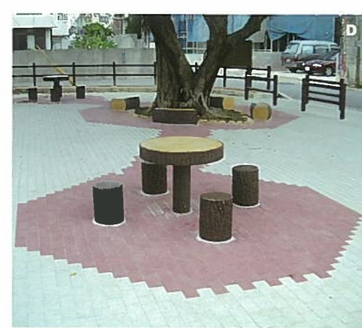
D. まちかど整備事業 インターロッキング 発注者：浦添市役所
