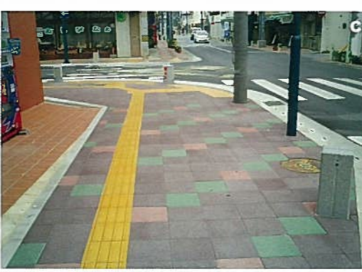
C. 嘉手納ロータリー 表層ガラス入り保水性平板 発注者：嘉手納町役場
