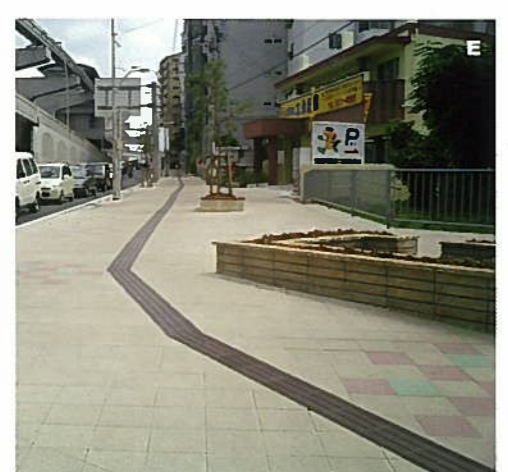
E. 国道330号線 (安里交差点) エコクリスタル平板ブロック 300×60 南部土木事務所
