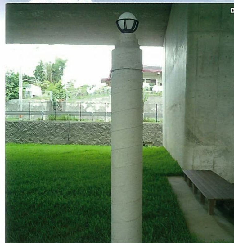
D. 花・水・緑の大回廊公園 照明灯 (300×H3,500) 表面ショットプラスチック仕上げ 発注者：南風原町役場
