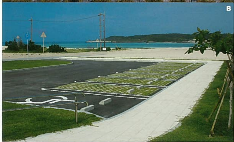
B. 野浦大橋 橋詰広場 表層ガラス 植生ブロック □400×100 発注者：北部土木事務所
