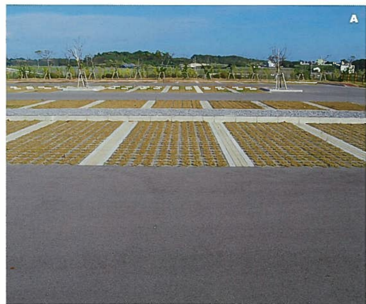
A 農業研究センター 保水性植生ブロック・インターロッキング 南部農林土木事務所
