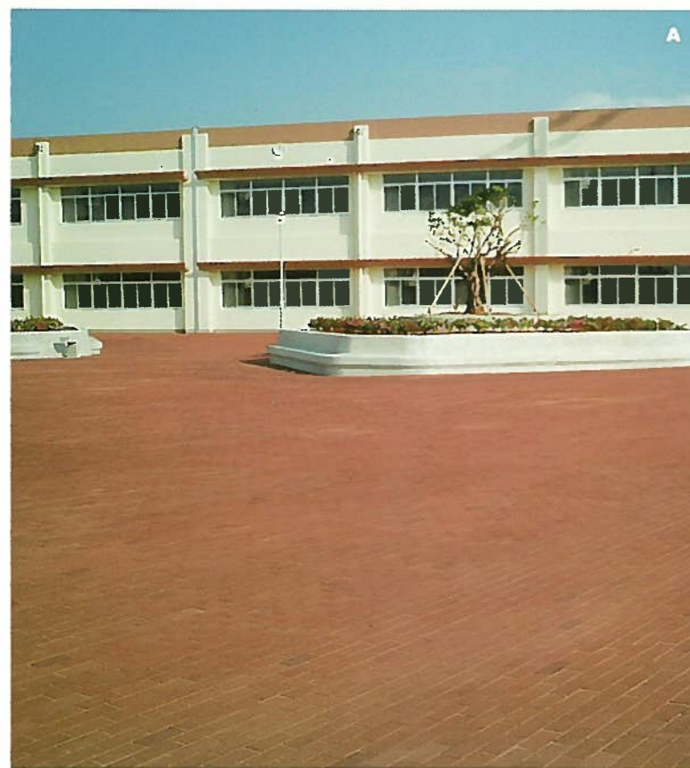
A. 嘉手納基地内学校 普通インターロッキングブロック(100×200×80) 発注者：那覇防衛施設局
