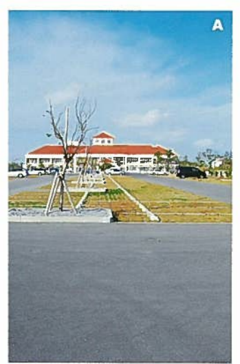
A 農業研究センター 保水性植生ブロック・インターロッキング 南部農林土木事務所
