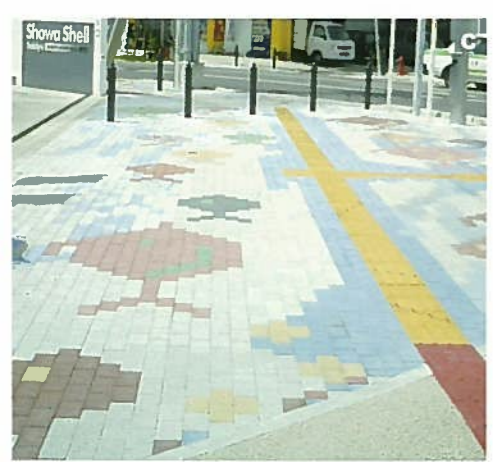
C. 銀座通り線 表層ガラス・インターロッキングブロック (100×200×60 100×200×80) 発注者：石川市役所建設課
