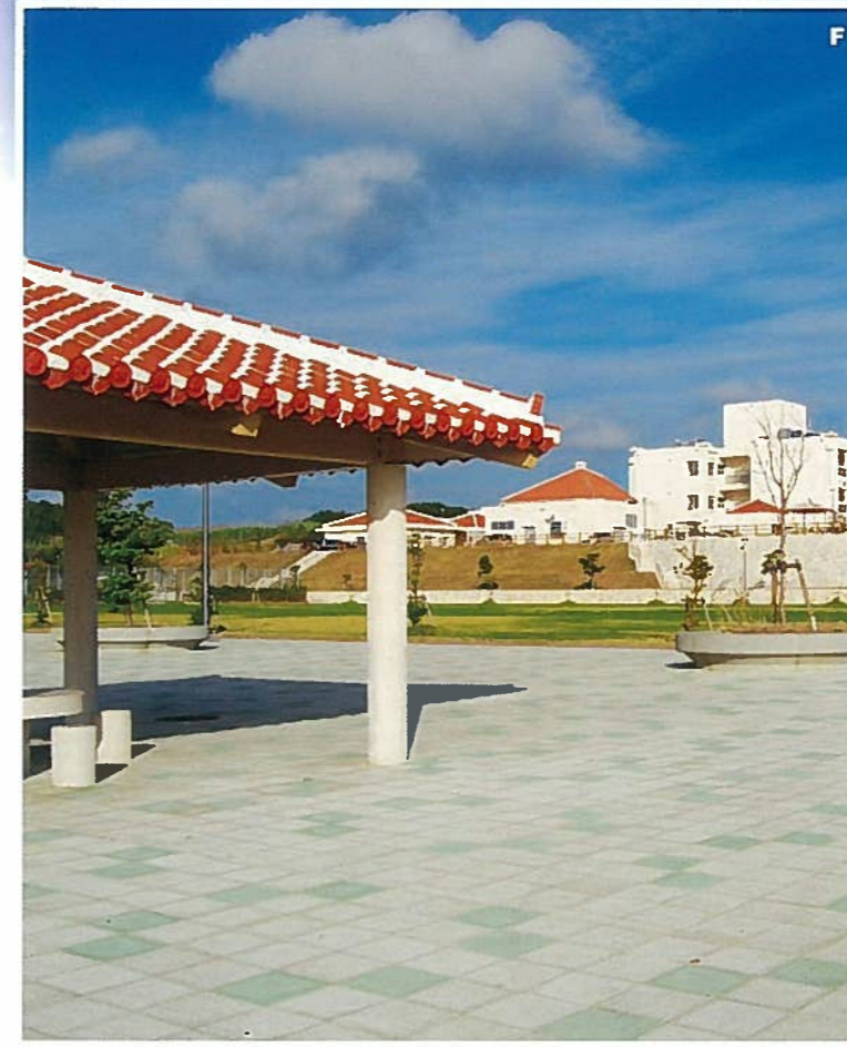
F. 農業研究センター 表層ガラスインターロッキング (100×200×80) 発注者：南部農林土木事務所
