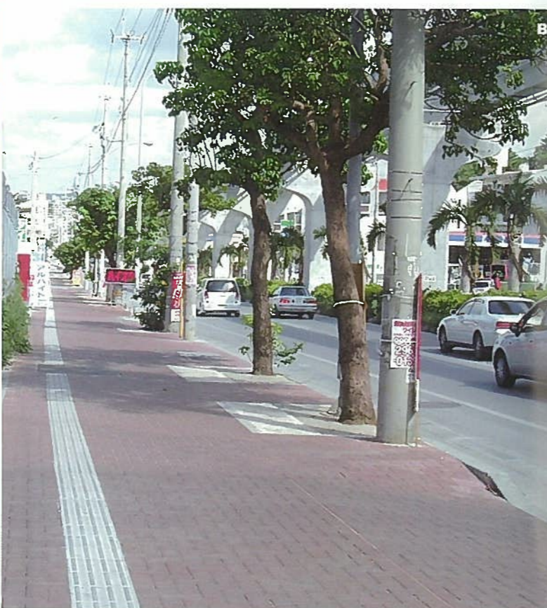
B. 県道那覇内環状線 エコクリスタルインターロッキングブロック (100×200×60) 発注者：沖縄県都市モノレール建設室
