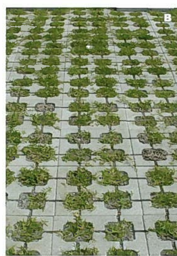
A 農業研究センター 保水性植生ブロック・インターロッキング 南部農林土木事務所
