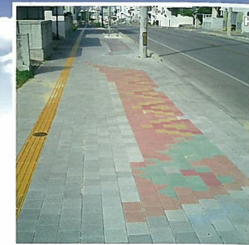
H. 糸満与那原線 エコクリスタルインターロッキング (100×200×60) 発注者：南部土木事務所
