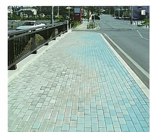
E. 石川西線 エコクリスタルインターロッキングブロック (100×200×60) 発注者：石川市役所建設課
