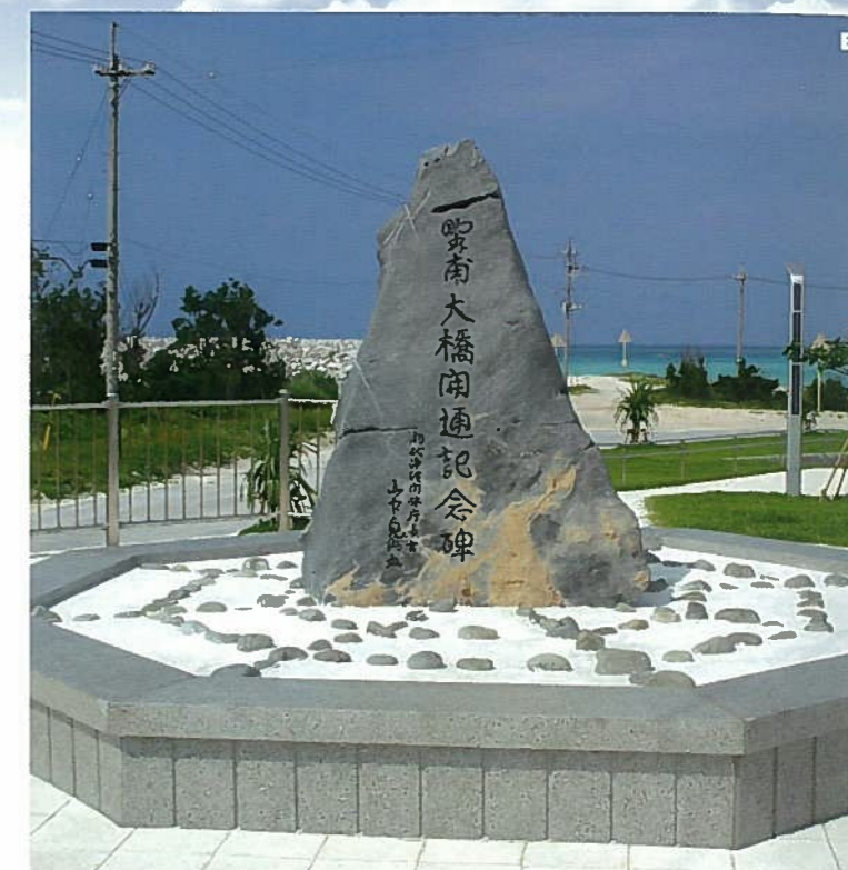
E. 野浦大橋 橋詰広場 表面磨き、側面ショット仕上げ ガラスリサイクル (八角ベンチ) 発注者：北部土木事務所
