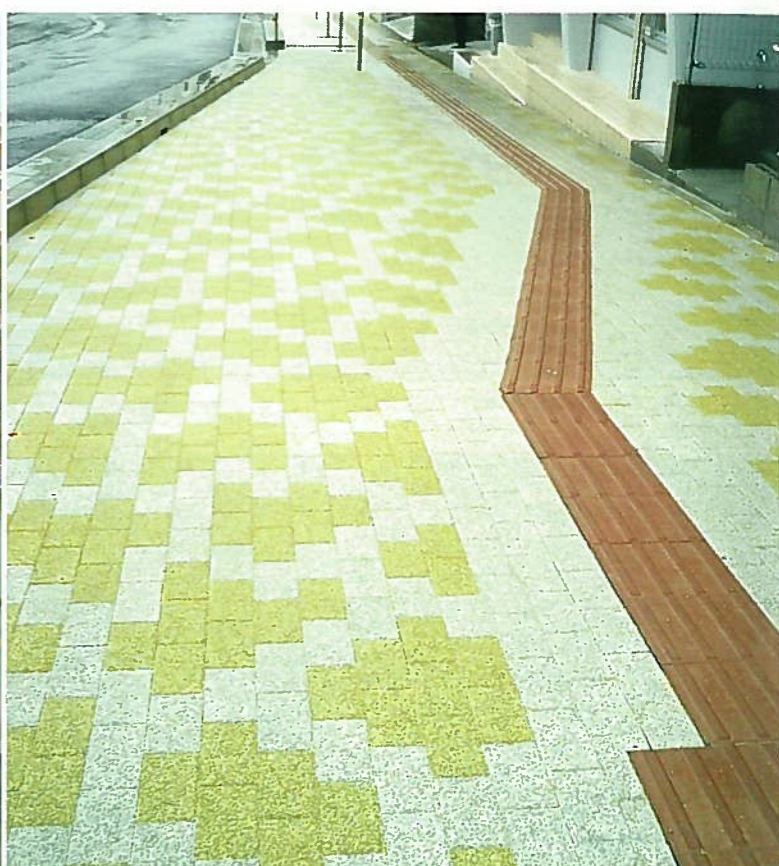
J. 県道153号線 エコクリスタルインターロッキングブロック (100×200×60) 発注者：南部土木事務所
