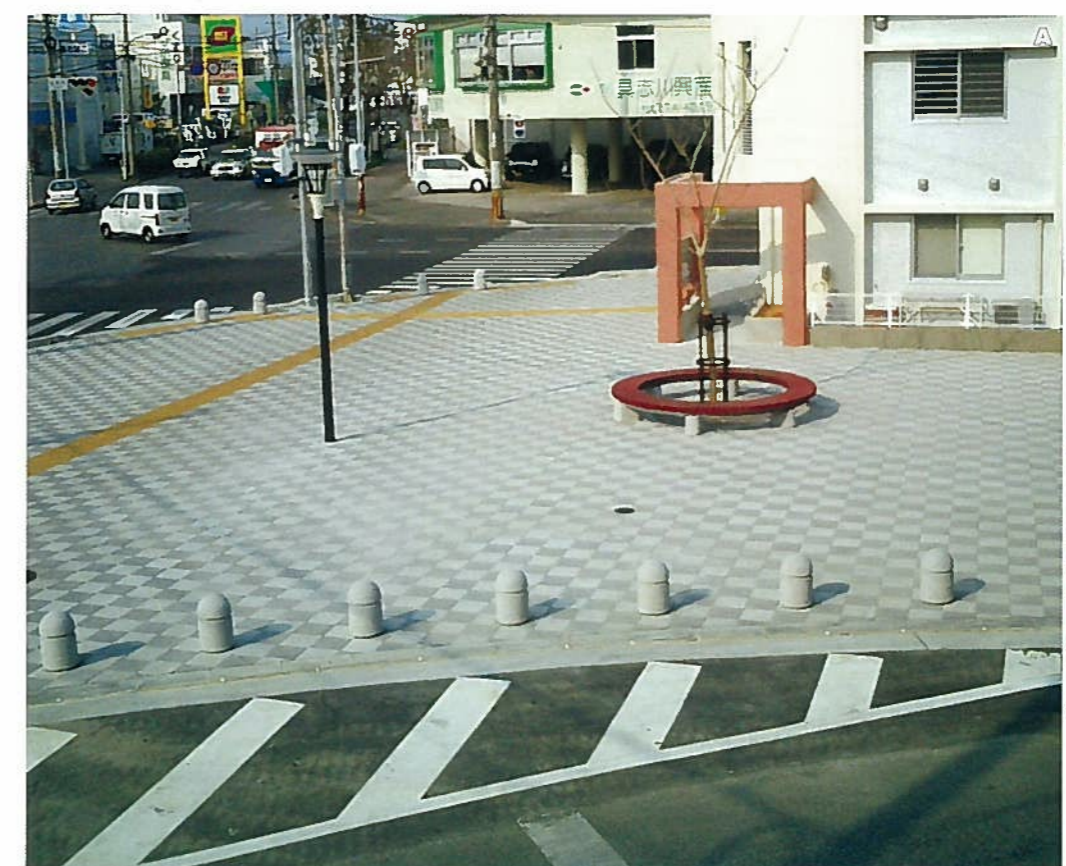
A. 栄野比具志川線 エコクリスタル保水性平板 (口300×60) うるま市役所
