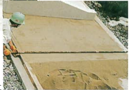
敷きモルタルの施工
